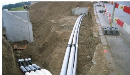
Rohrblock ab TS Feld und Schacht Feld, 12.08.2011
