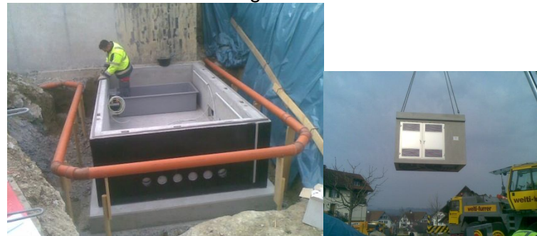
Neubau Trafostation Ruetig, 23.03.2009
